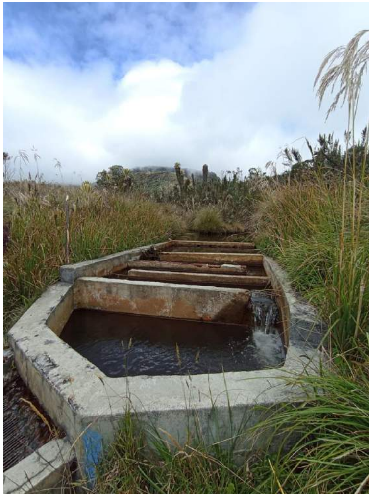
Ilustración 15: Acueducto de Gualmatán en el páramo El Sinaí (Usamá, 2023.)
